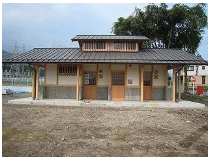
[ トイレ全景写真 ]
