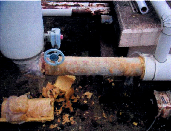
保温、ラッキング取外状態
