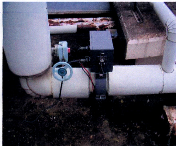
保温、ラッキング復旧 取付完了状態
